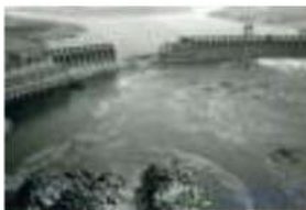
Іл. 40.8. Зруйнована вибухом гребля Дніпрогесу в 1941 р.
