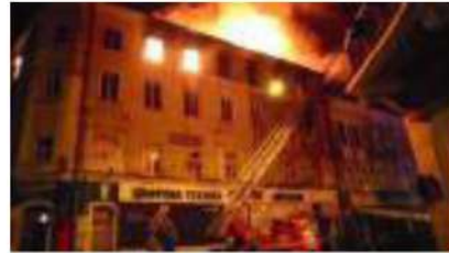
Іл. 41.5. Пожежа в центрі Тернополя в 2015 р.
