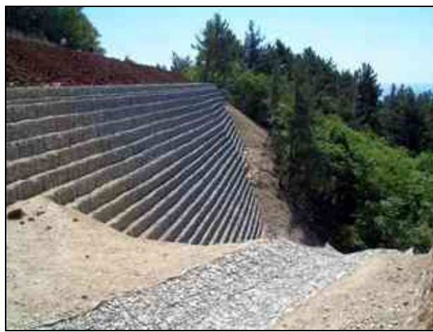
Рис. 63. Конструкції для укріплення схилів
