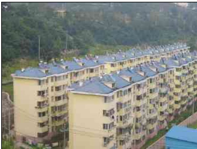
Рис. 105. Сонячні водонагрівачі на дахах у китайській провінції Хубей
