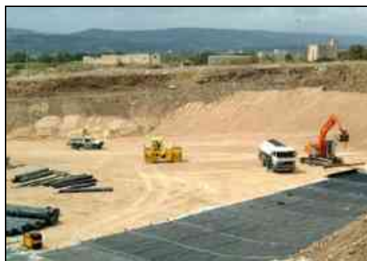
Рис. 56. Вирівнювання поверхні
