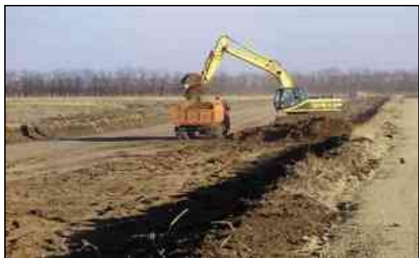
Рис. 55. Зняття родючого шару ґрунту
