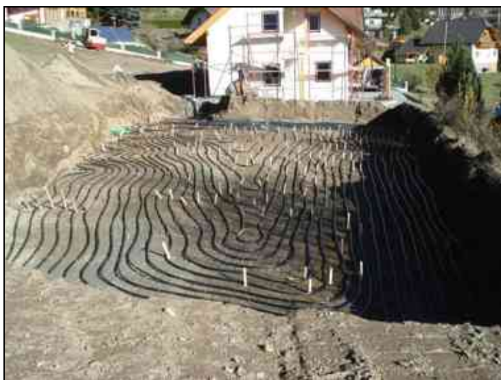
Рис. 124. Ґрунтові колектори
