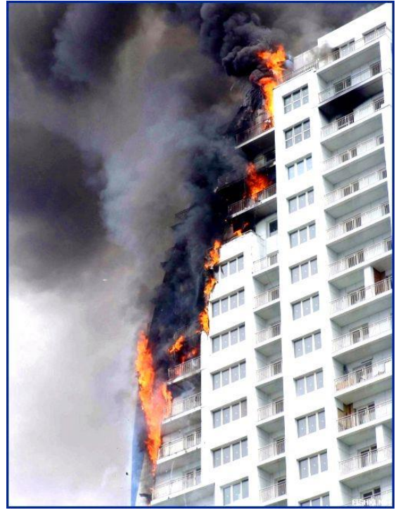
Рис. 2.22. Пожежа будинку з SIP панелей
