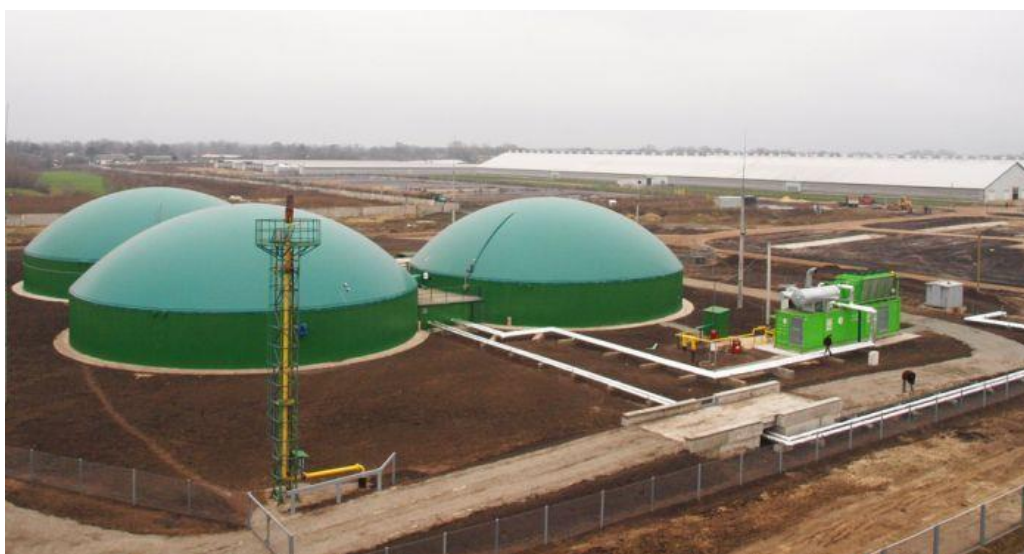
Рисунок 4.4 – Метантенки біогазової установки
