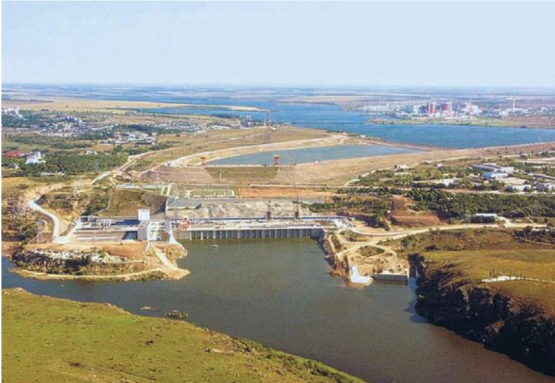
Рисунок 6.1 – Ташлицька ГАЕС (Потужністю 0,9 млн. КВт утворює з Південно-Українською АЕС потужністю 3 млн. КВт енергокомплекс, який працює за оборотною схемою без гідравлічного зв'язку водойми-охолоджувача АЕС і водосховищ ГАЕС)
