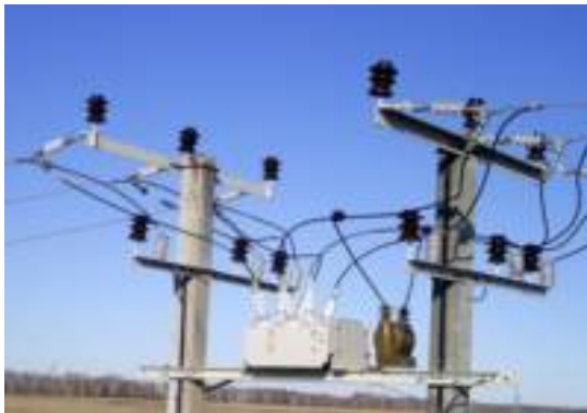
Рис. 14.9. Вакуумний реклоузер РВА / TEL на повітряній лінії напругою 10 кВ
